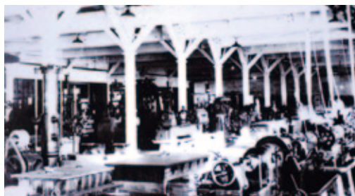
駒方校舎 機械実習室
